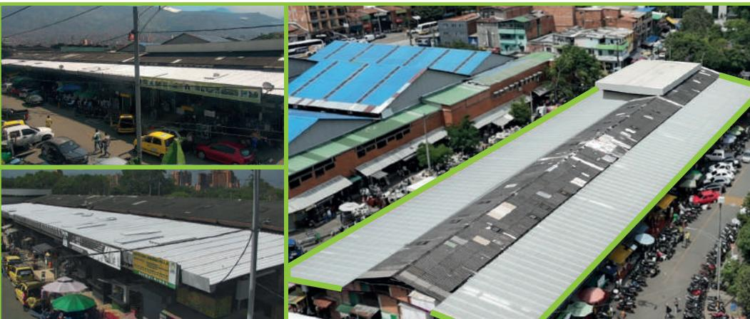
El proyecto contempló la remoción de la estructura metálica existente, instalación de nueva cubierta termoacústica, canales pluviales, bajantes y trabajos complementarios de refuerzo estructural.
